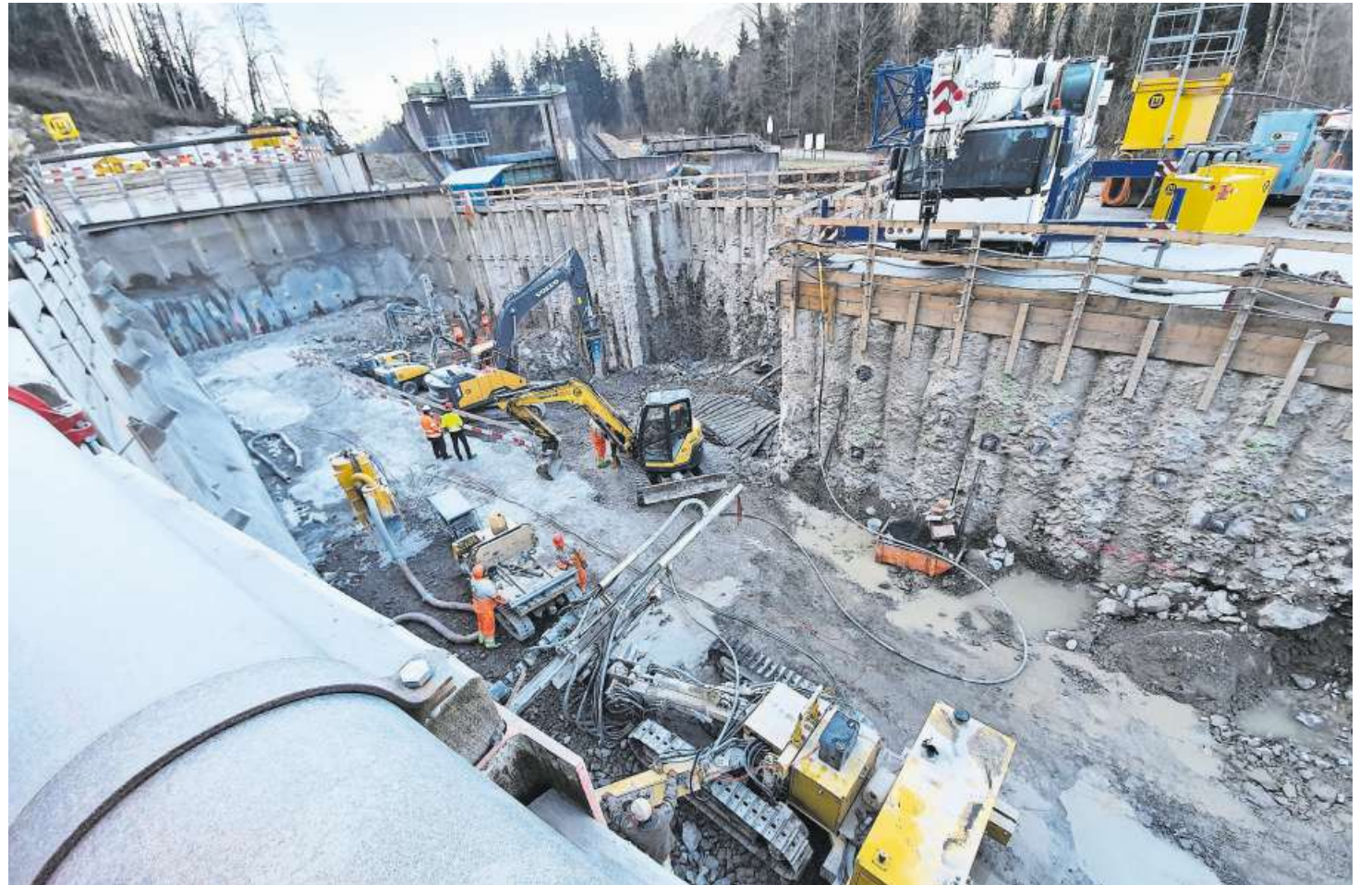
Die Baustelle für das Auslaufbauwerk des Hochwasserentlastungsstollens in Alpnach.
